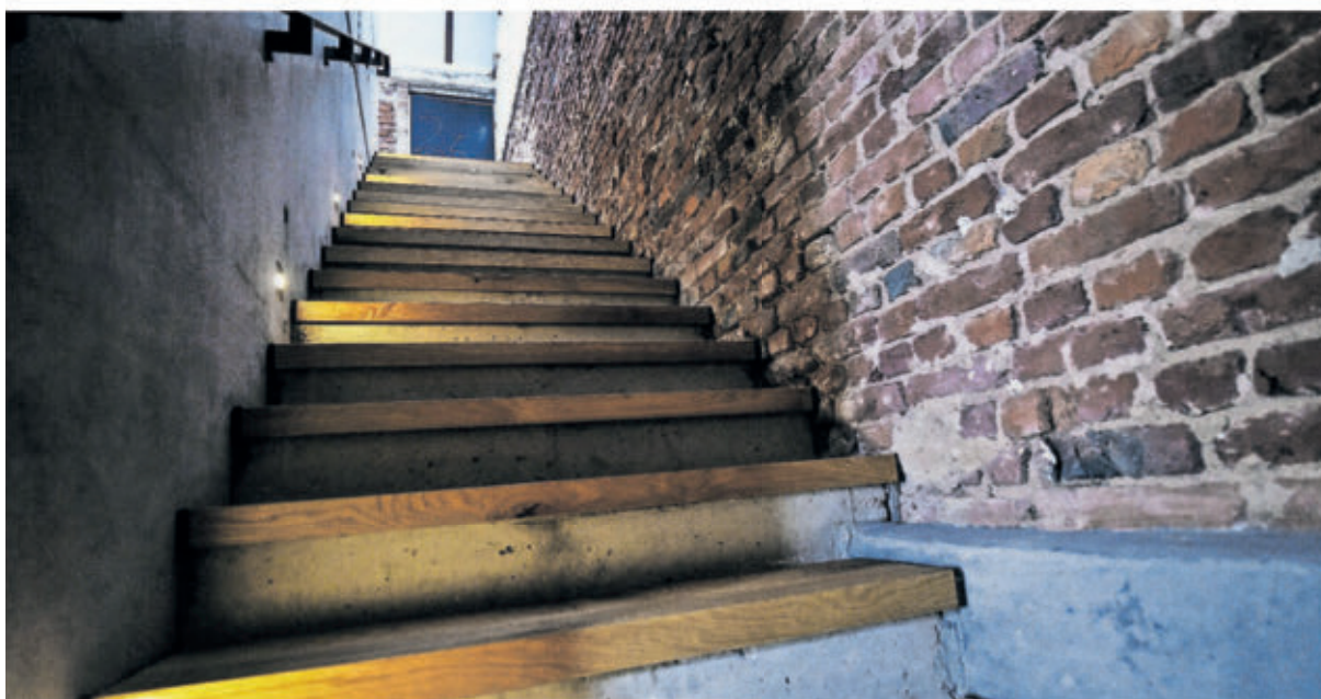
Einer der beiden Treppenaufgänge.
