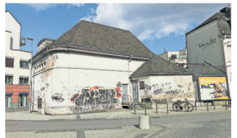
So sah das Trafohaus vor der Sanierung aus.
