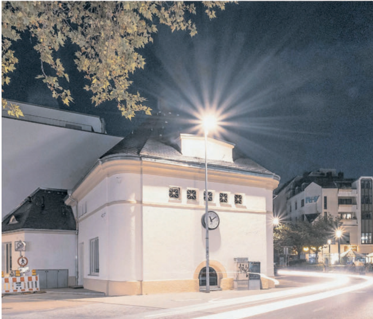
Das „neue“ Trafohaus in Trier (Pferdemarkt/Kutzbachstraße) bei Nacht.
