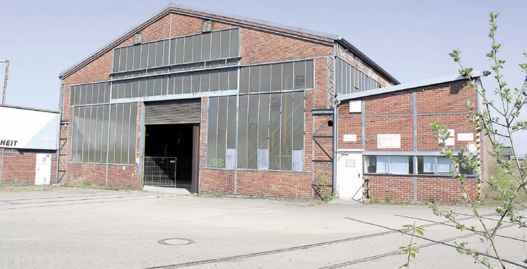
Die alte Weichenfabrik in Barop soll in den kommenden Jahren zu einem modernen Wohnquartier umgebaut werden.
